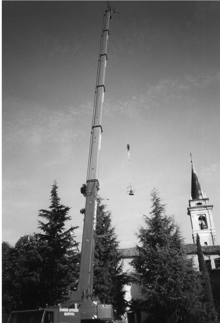
Un momento della rimozione delle campane dalla torre con la gru
